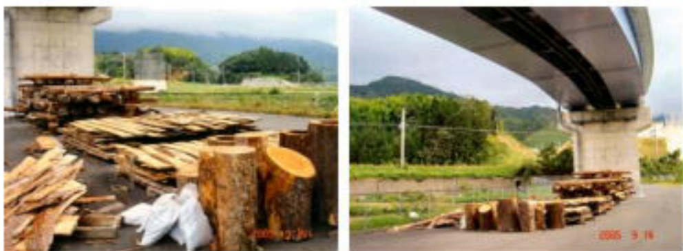
京都縦貫自動車道 高架下 (宮津市喜多)
