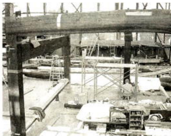
台風23号で被害を受けた天橋立のマツを再利用した大梁が据えられた澤井家住宅(京田辺市大住)
